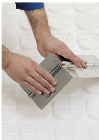
Teplorozvodný modul s místem žádaného zlomu
